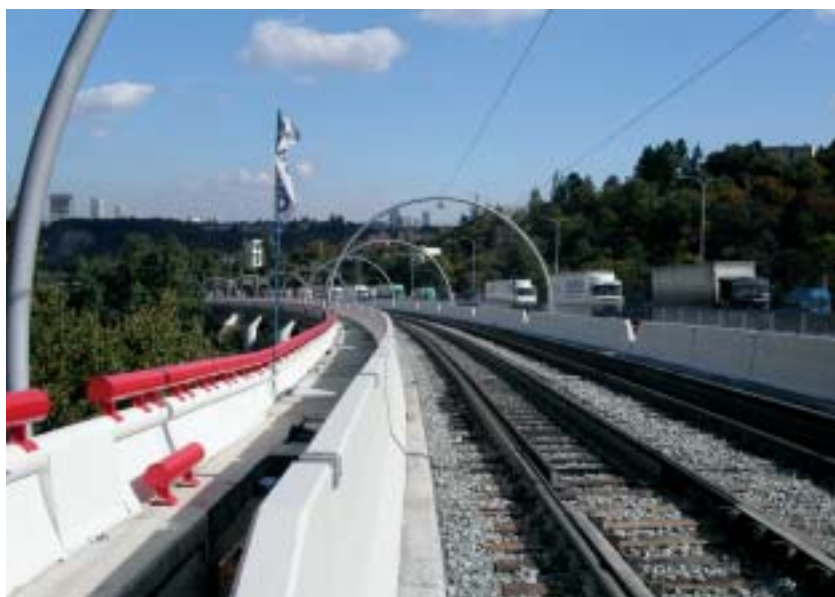
Obr. 7 Celkový pohled na most, chodník pro pěší je vymezený zádržnou stěnou a částí vzpěry
