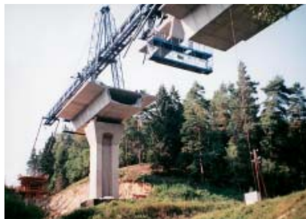
Obr. 2 Montáž segmentů na mostě v Bělé pod Bezdězem
