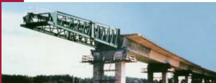
Obr. 1 Postupné vysouvání nosné konstrukce mostu Čekanice
