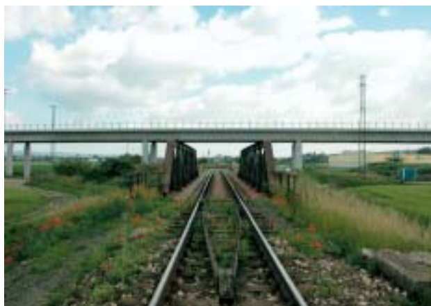
Obr. 6 Křížení estakády s železnicí Fig. 6 Crossing of the elevated road with the railway
