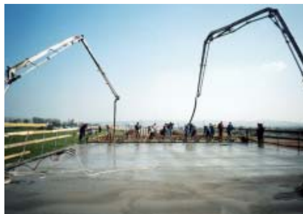
Obr. 5 Betonáž nosné konstrukce Fig. 5 Concreting of the bearing structure
