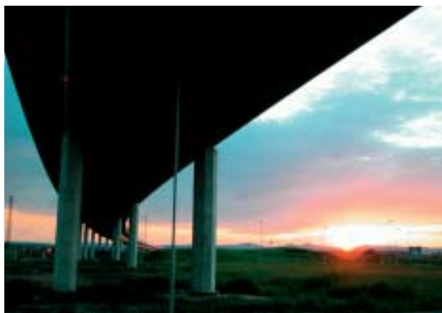
Obr. 4 Pohled na estakádu při západu slunce Fig. 4 A view of the elevated road during sunset
