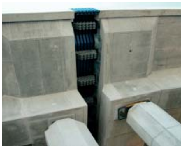
Obr. 10 Oddílatování mostu estakády a rozpletu
