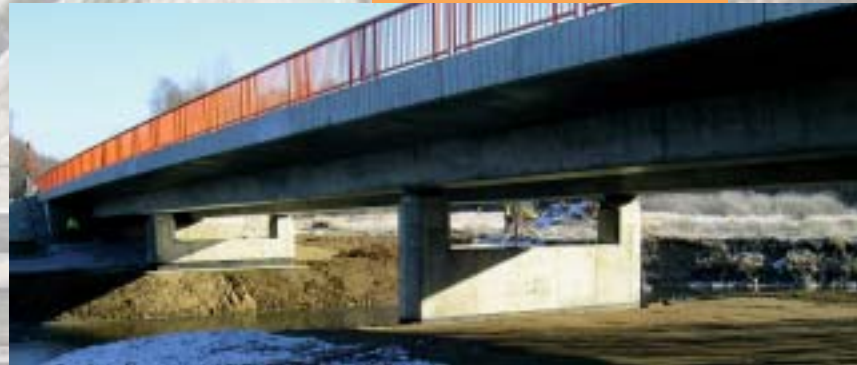
Most na II/141 přes řeku Blanici Bridge, km II/141, across the Blanice River
