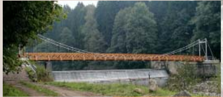
Lávka pro pěší v Benešově u Semil A footbridge in Benešov near Semily
