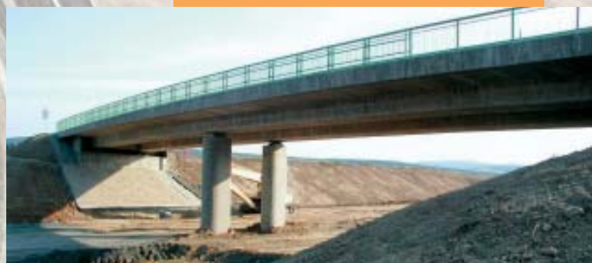
Dálnice D5, část Ejpovice – Útušice, nadjezd přes D5 D5 motorway, part Ejpovice – Útušice, a flyover over D5
