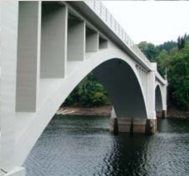
Most přes Pastvinskou přehradu, rekonstrukce Bridge across Pastvinská Dam, reconstruction
