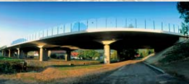
Chrastava, zkapacitnění silnice I/13 – most Chrastava Chrastava, increasing capacity of I/13 road – Chrastava Bridge
