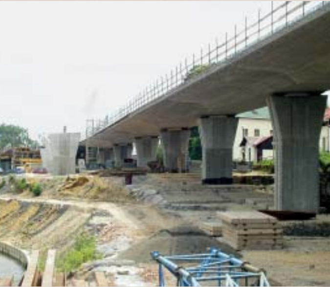
Liberec, Přeložka silnice I/14 – most přes Poštovní náměstí Liberec, I/14 road diversion – the bridge across Poštovní Square
