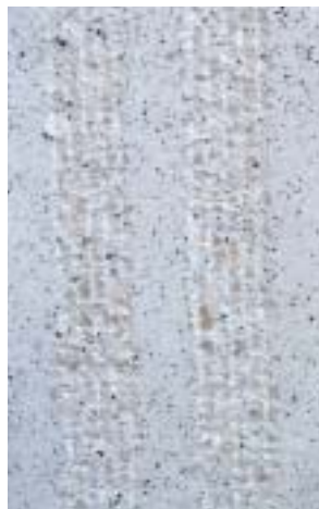
Obr. 2 Úprava povrchu betonového obvodového pláště pemrlovanými pásy
