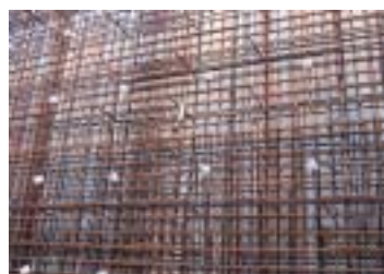
Obr. 2 Výztuž stěny s PE trubkami
