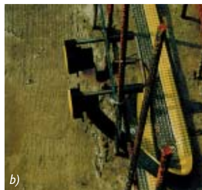
Obr. 4 a), b) Umístění injektážních hadic v reálných podmínkách
