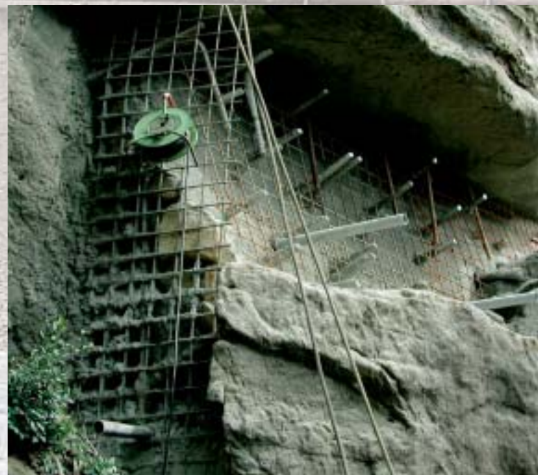
Sanace skal v Hřensku Sanitation of rocks in Hřensko
