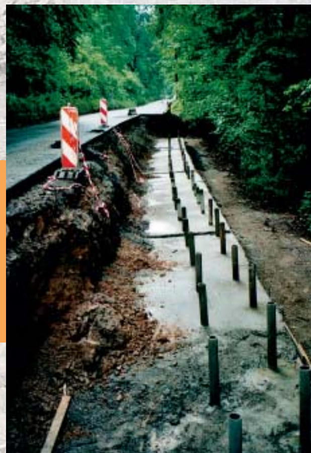
Sanace krajnic na silnici I/62 Děčín- Hřensko, II. etapa Maintenance of shoulders on I/62 road Děčín- Hřensko, stage II
