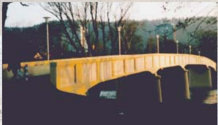
Rekonstrukce Plynárenské lávky v Karlových Varech Reconstruction of Plynárenská footbridge in Karlovy Vary
