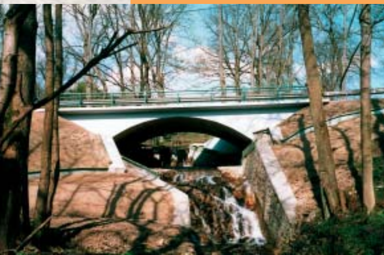
Rekonstrukce silnice II 201 Broumov-Farský rybník Reconstruction of II 201 road Broumov-Farský pond
