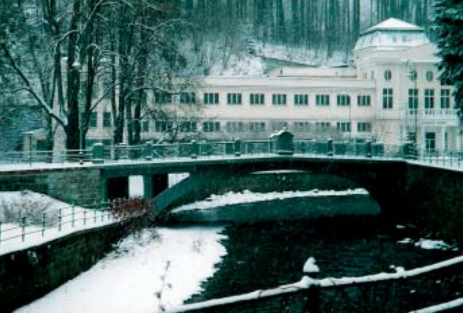
Rekonstrukce Karlova mostu v Karlových Varech Reconstruction of Charles Bridge in Karlovy Vary
