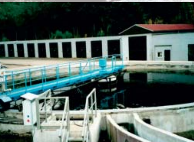
Rekonstrukce ČOV v Karlových Varech Reconstruction of a wastewater treatment plant in Karlovy Vary
