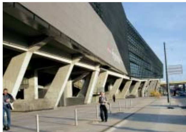
Obr. 3 Jihovýchodní křídlo podporované mohutnými rámy
