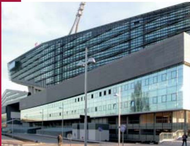
Obr. 1 Centrum T-Mobile ve Vídni, severozápadní fasáda
