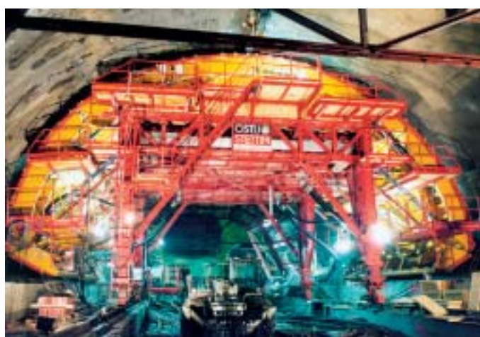
Obr. 3 Primární ostění stanice Fig. 3 Primary lining of the station
