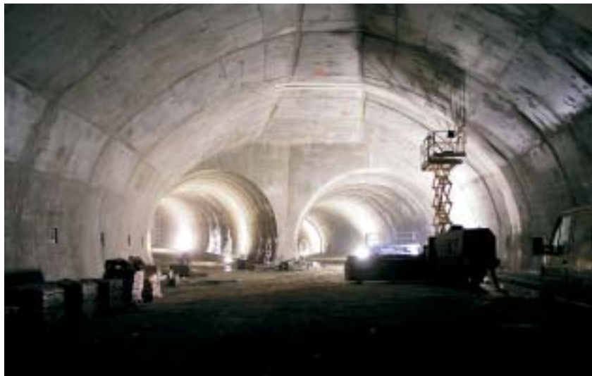
Obr. 8 Definitivní ostění západního rozpletu Fig. 8 Final lining of the West tunnel branching
