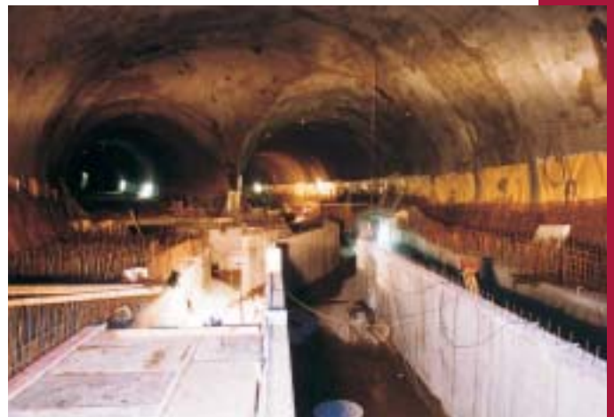
Obr. 4 Betonáže spodní části Fig. 4 Concreting of the lower part
