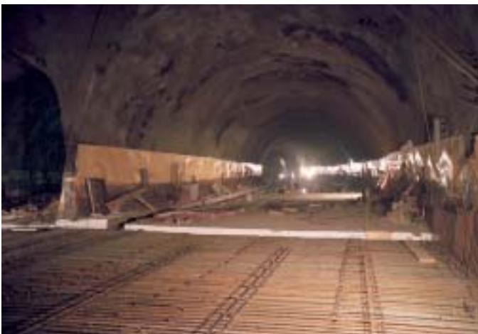
Obr. 3 Výtzuž mostovky Fig. 3 Reinforcement of the deck
