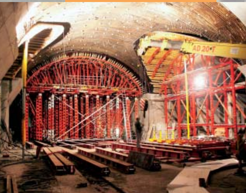
Bednění klenby zálivu ZTT v místě napojení podzemní trafostanice a propojky Casing of Vaulting of the West Tunnel Tube Bay in the Connection place of the Underground Transformer station and the Tunnel Interconnection
