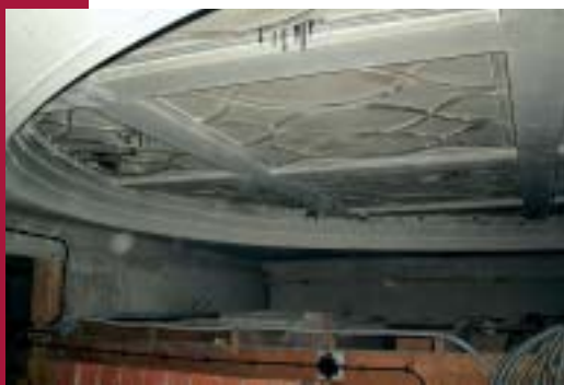
Obr. 11 Prosklení stropu objektu Vodičkova pod pohledem
