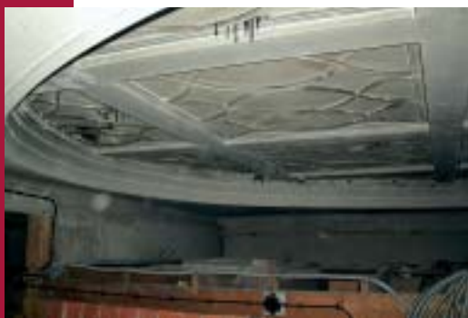
Obr. 11 Prosklení stropu objektu Vodičkova pod pohledem
