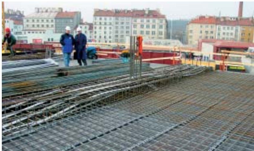
Obr. 5 Uložené kabely před zaklopením horní výztuží Fig. 5 Tendons placed before covering by the top rebar
