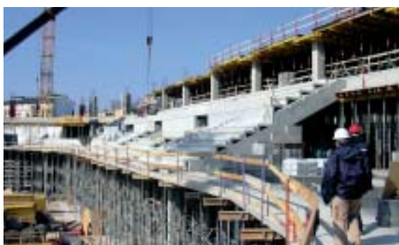
Obr. 6 Montáž prefabrikovaných tribun probíhala současně s prováděním monolitu
