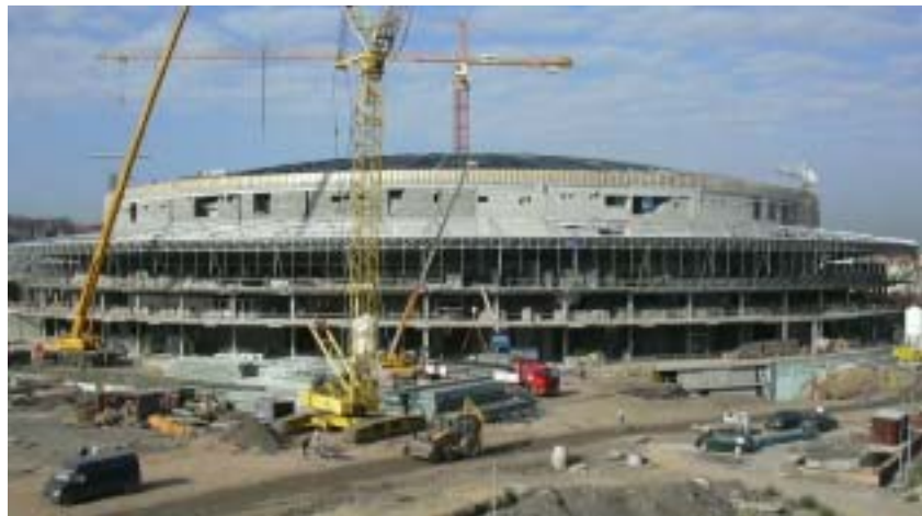
Obr. 1 Pohled na dokončenou konstrukci Fig. 1 View of the finished structure
