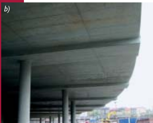
Obr. 5 Charakteristická konstrukce obvodového prstence s plochými předpjatými průvlaky – a) schema, b) realita
