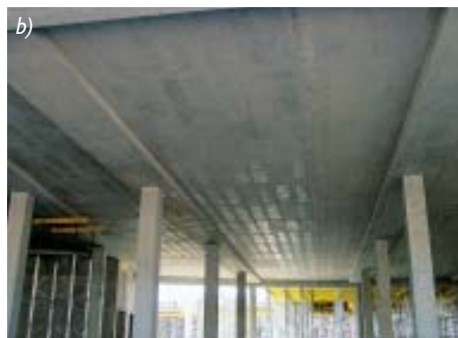
Obr. 4 Charakteristická konstrukce velké arény s plochými průvlaky – a) schema, b) realita
