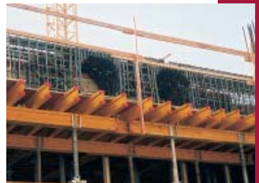
Obr. 12 Připravená výztuž trámy s vynechanými prostupy Fig. 12 The prepared reinforcement of a beam with temporary blockouts
