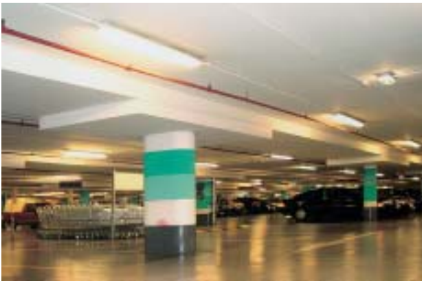
Obr. 8 Prostory podzemních garáží Fig. 8 Spaces of underground garages
