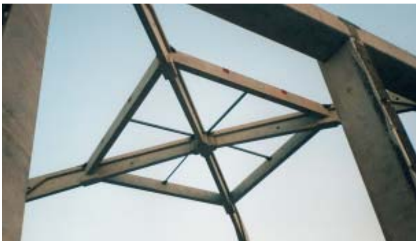
Obr. 18 Nosná betonová prefabrikovaná konstrukce podepřená před zmonolitněním ve středu ocelovou příhradovou konstrukcí
