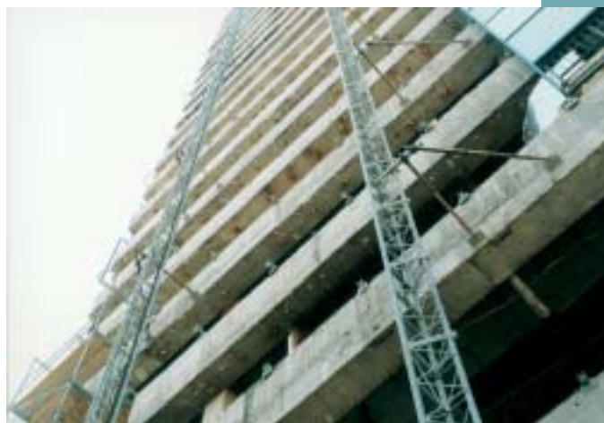
Obr. 6 Sarajevské „dvojče“ během rekonstrukce
