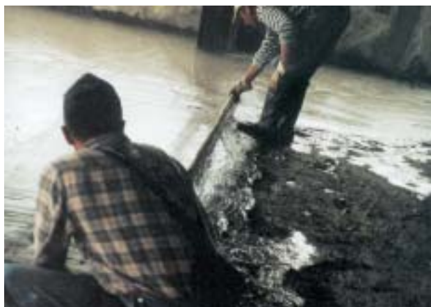
Obr. 7 Pokládka pěnobetonu
