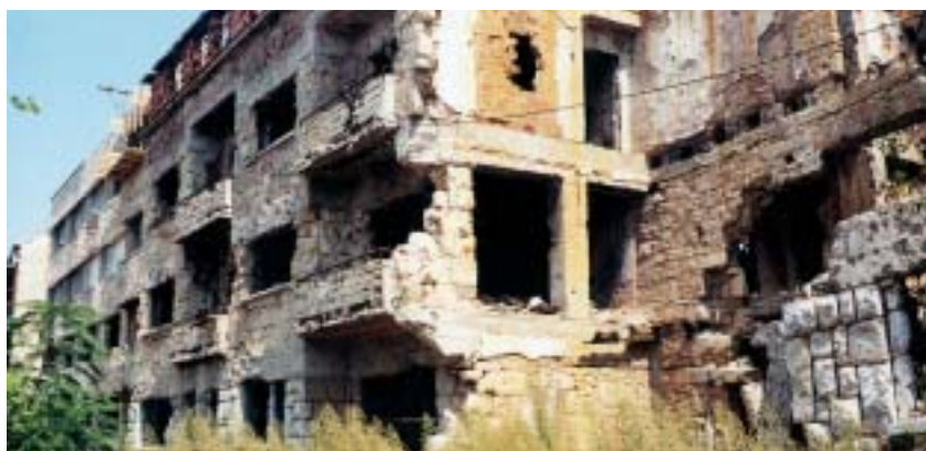
Obr. 3 Ruiny bytového domu v Mostaru
