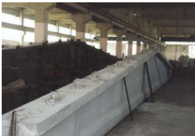
Obr. 5 Obnovená výroba prefabrikátů, některé nosníky byly dlouhé až 28 m
