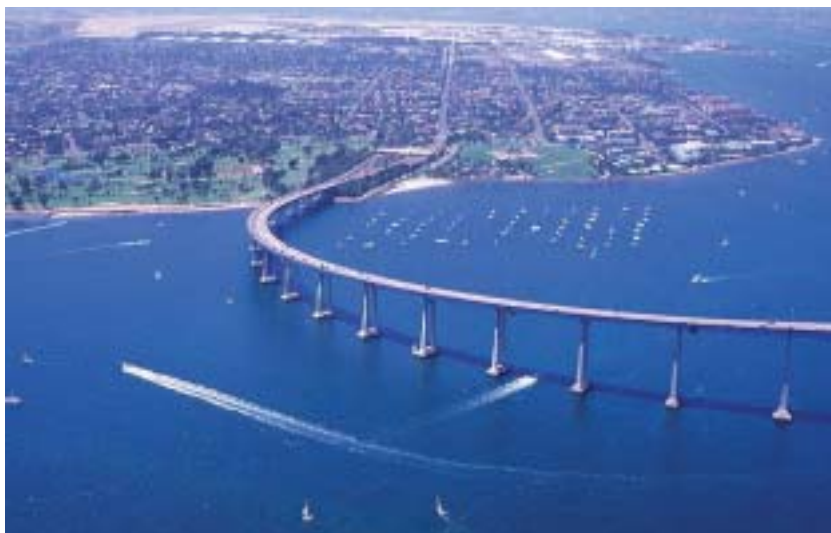
Obr. 4 Coronado Bridge, San Diego, Kalifornie, USA
