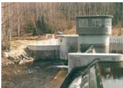
Obr. 5 Nový jez na Vltavě v Loučovicích Fig. 5 New weir on the Vltava River in Loučovice
