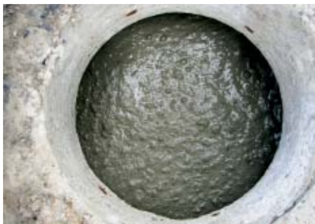
Obr. 8 Kolektor v Brně – stabilní SCC v bednění Fig. 8 Collector in Brno – stable SCC in formwork
