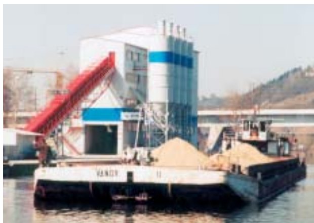
Obr. 14 Současná výrobní transportbetonu s uskladněním kameniva v zásobnících (Praha–Holešovice, Skanska Transbeton, s. r. o.) Fig. 14 Recent mixing plant with aggregate stored in silos
