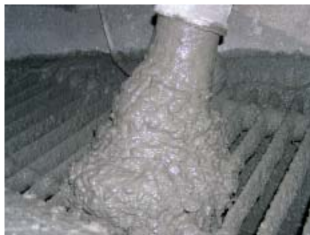
Obr. 5 Detail betonové směsi čerpané 30 m pod zem pro betonáž klenby ve stanici metra Kobylisy, TBG Metrostav, s. r. o.
