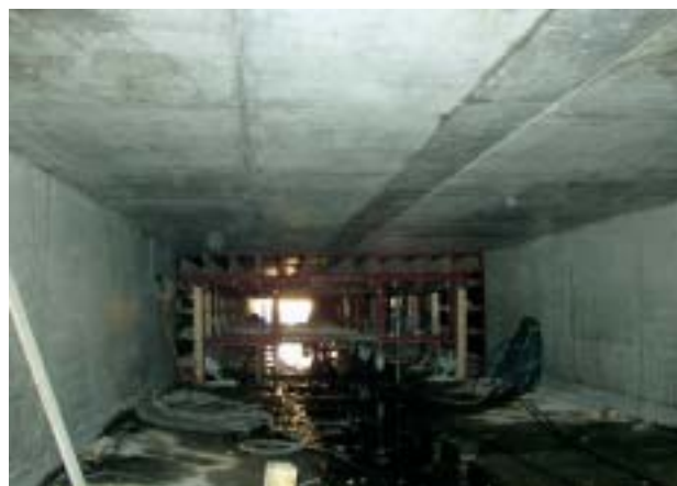
Obr. 9 Kolektor v Brně – odbedněná konstrukce Fig. 9 Collector in Brno – the structure after formwork removal
