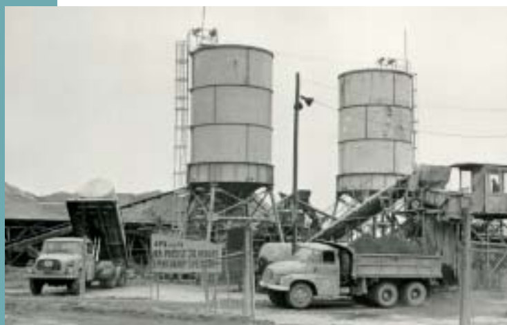
Obr. 12 Výrobní transportbetonu z počátku 70. let (Praha – Ďáblice) Fig. 12 Mixing plant at first 70. years (Prague – Ďáblice)
