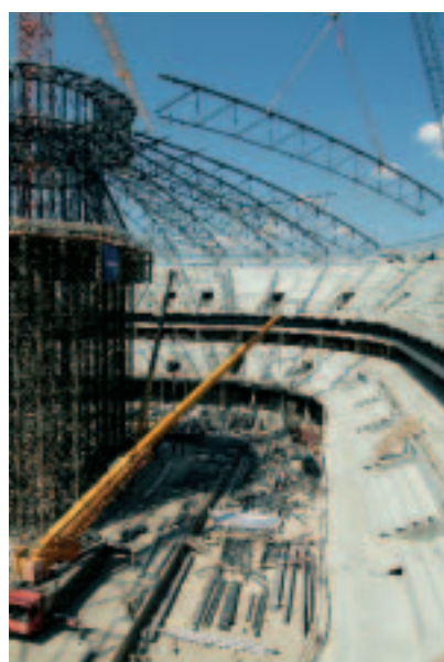
Obr. 5 Nad dokončenými tribunami je sestavována ocelová konstrukce zastřešení, červen 2003
