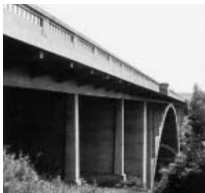
Obr. 4 Dálniční most u Senohrab
