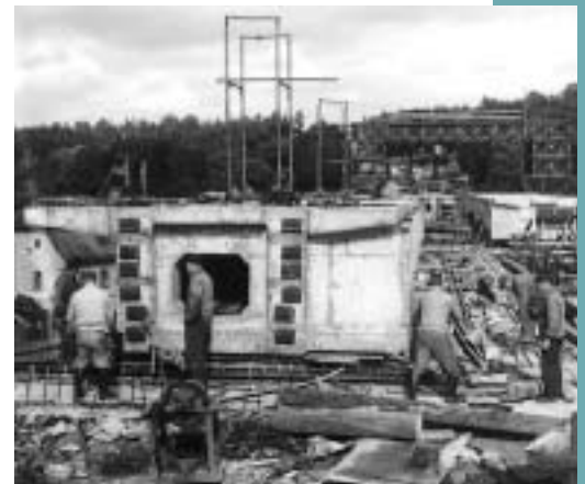
Obr. 12 Trám mostu přes Jihlávku Fig. 12 Girder of the bridge over the Jihlava brook
