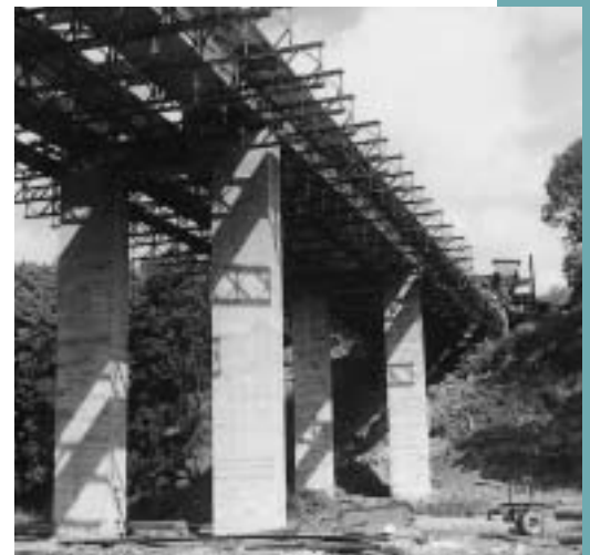
Obr. 13 Lešení mostu přes Jihlávku Fig. 13 Scaffolding of the bridge over the Jihlava brook
