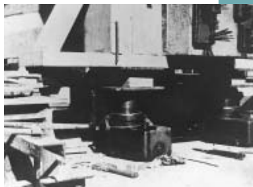
Obr. 4 Zvedání trámu s podlahy
