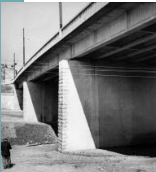
Obr. 9 Most přes Koželužský potok Fig. 9 Bridge over the Koželuh brook
