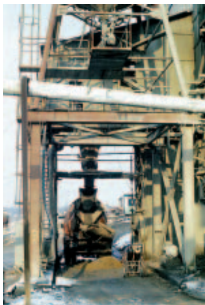
Obr. 5 Plnění automíchače Fig. 5 Loading a truck mixer
