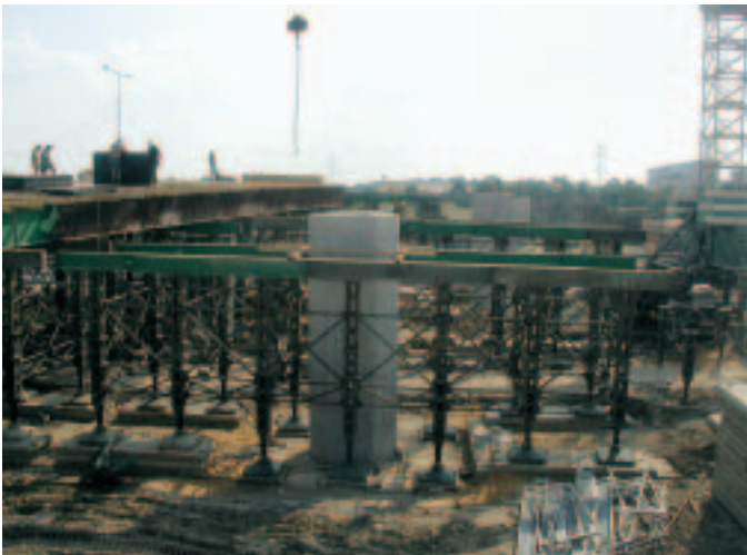
Obr. 3 Skruž Fig. 3 Steel centering
