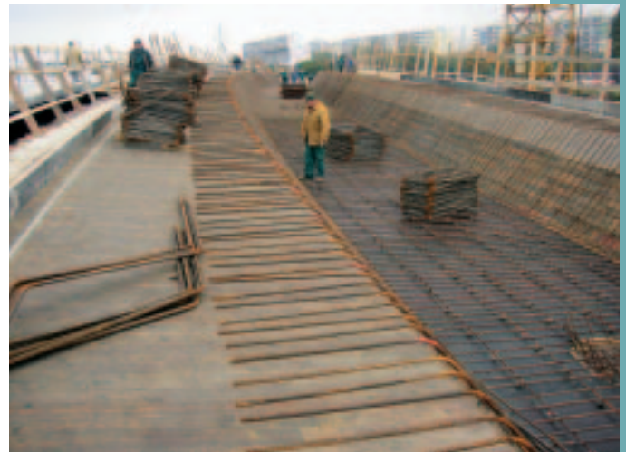
Obr. 4 Bednění nosné konstrukce Fig. 4 Formwork of the bridge superstructure
