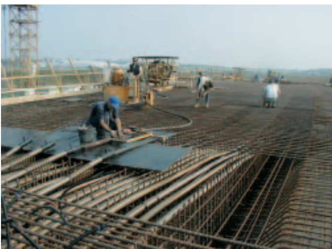
Obr. 5 Betonářská a předpínací výstuž Fig. 5 Reinforcement bars and prestressing tendons
