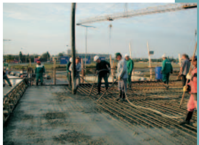
Obr. 6 Betonáž nosné konstrukce Fig. 6 Placing of concrete
