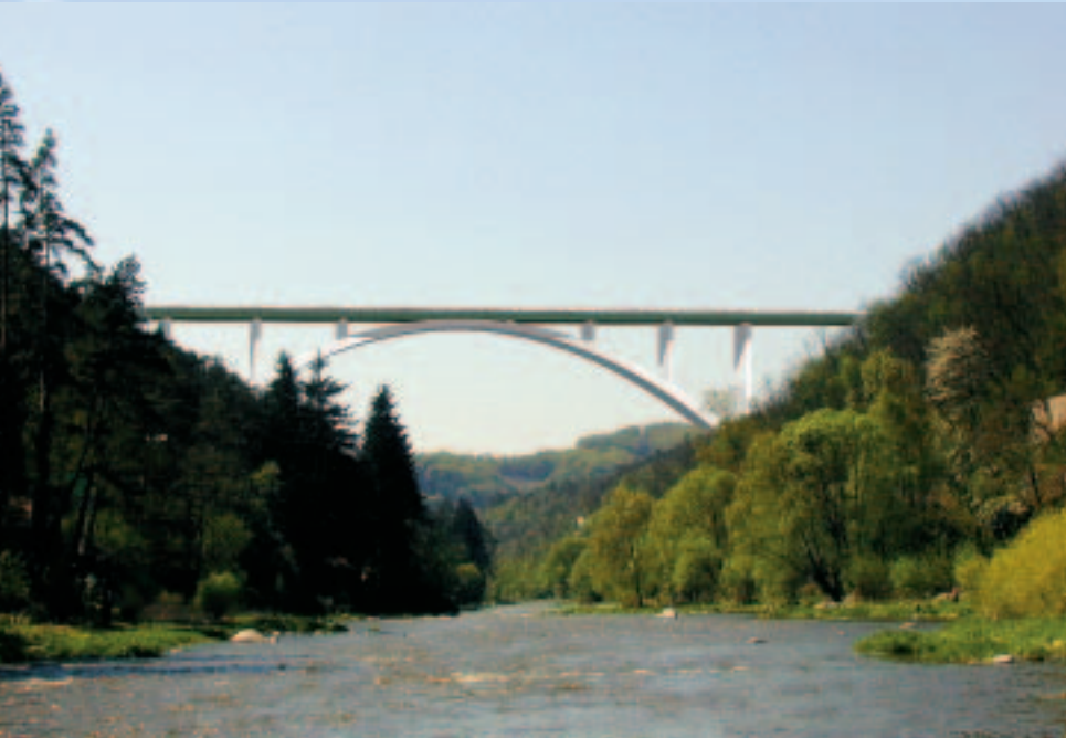
Návrh přemostění údolí Sázavy na dálnici D3 – oblouk o rozpětí 250 m Proposed crossing of the Sázava valley on the D3 motorway – arch, 250 m span
