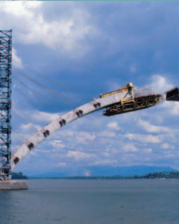
Letmá betonáž oblouků s vyvěšováním, Sungai Dinding, Malaysia Balanced cantilevering with back-stays, Sungai Dinding, Malaysia
