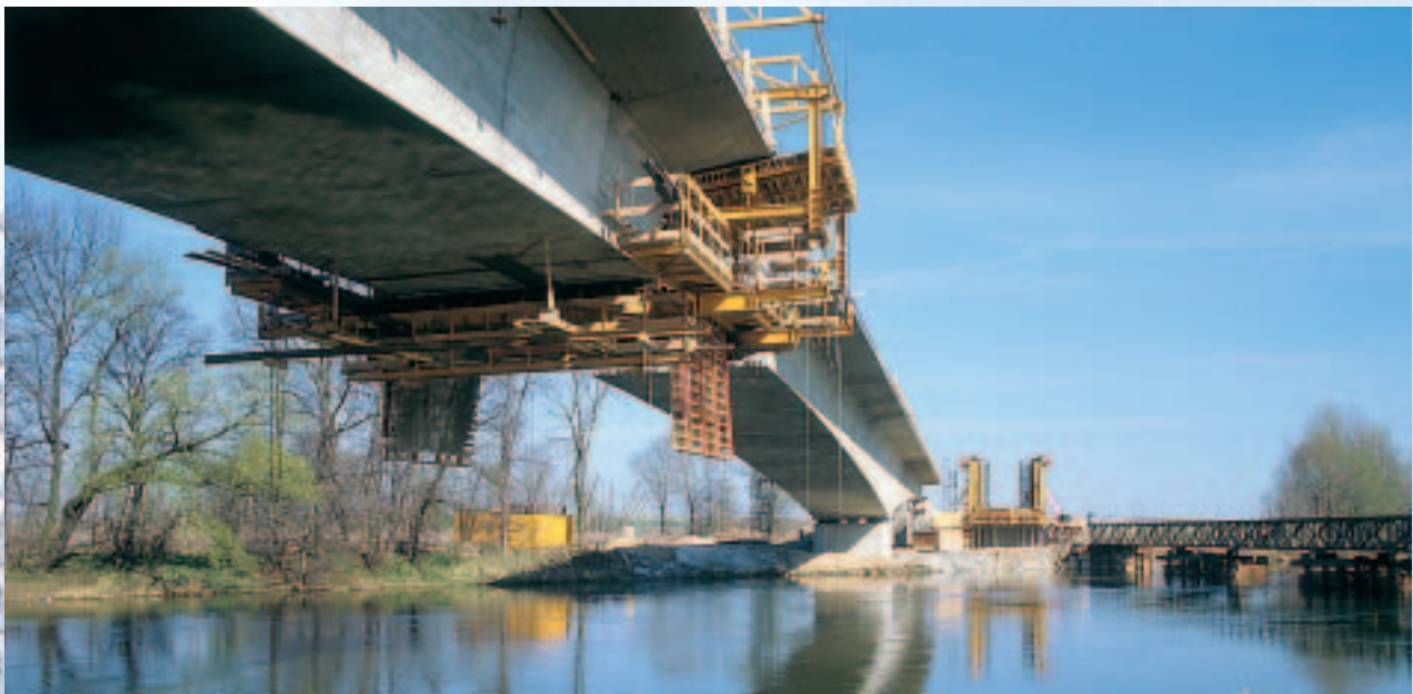
Letmá betonáž mostu přes Ohři u Doksany na dálnici D8 Balanced cantilevered bridge over the Ohře at Doksany on the D8 motorway
