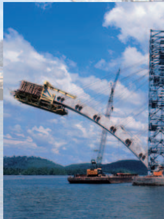
Montáž segmentového mostu na silnici I/7 u Chomutova Erection of the segmental bridge on the I/7 highway at Chomutov
