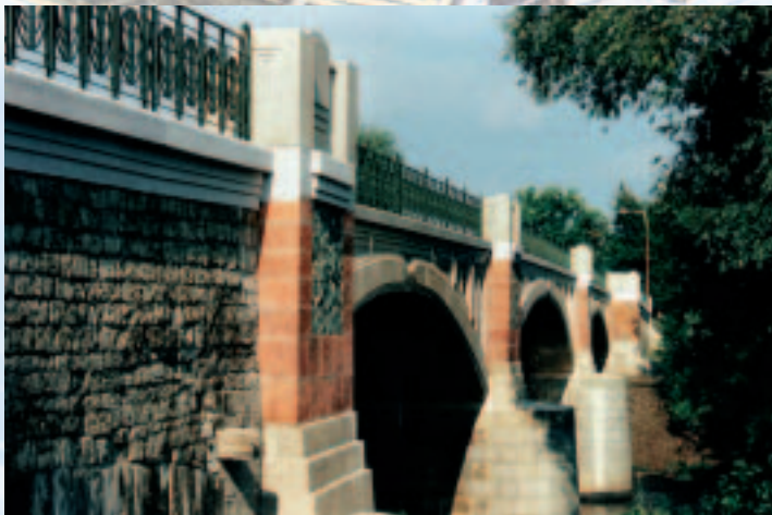
Betonový most v Postoloprtch z roku 1909 po rekonstrukci Concrete bridge at Postoloprty dated 1909 after rehabilitation
