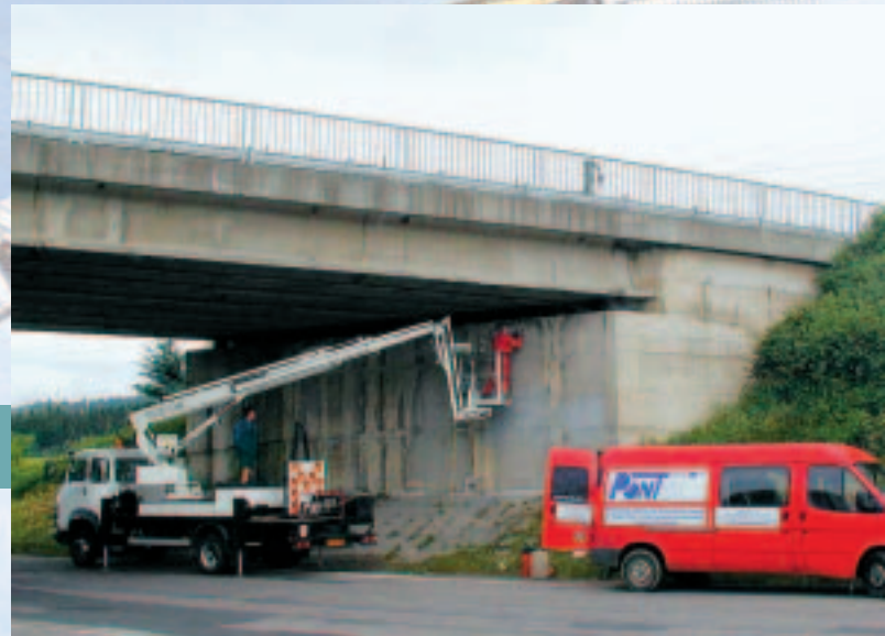
Diagnostický průzkum mostu v Klášterci nad Ohří Inspection and assesment of the bridge at Klášterec nad Ohří
