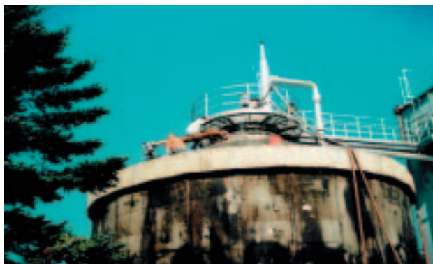
Obr. 1 Pohled na nádrž ČOV v Turnově před sanací po odstranění opláštění Fig. 1 View of the tank in WWTP Turnov with demolished cladding
