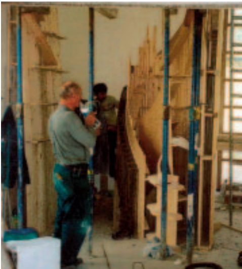
Obr. 2 Příprava bednění a výztuže Fig. 2 Preparation of formwork
