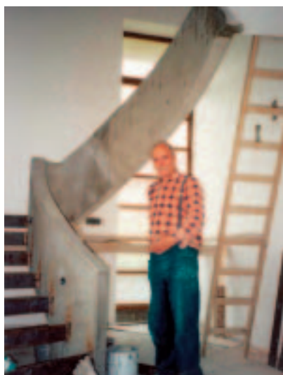
Obr. 5 Čtvrť odbedněná schodnice a spokojený mistr tesař
