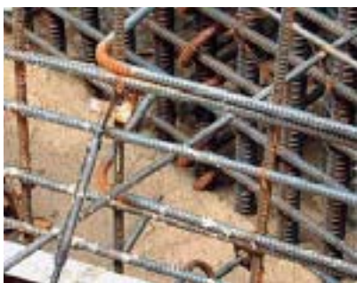
Obr. 6 Hustě armovaný segment mostu Fig. 6 Densely reinforced bridge segment
