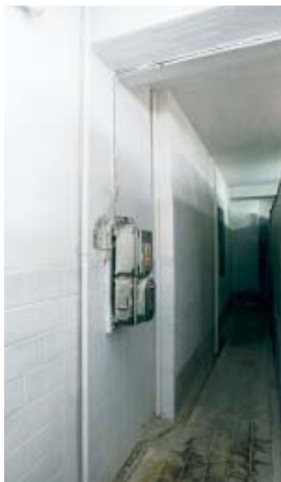
Obr. 6 Provozní objekt stanice IB Florenc po provedení zatěsnění stěn a stropu
