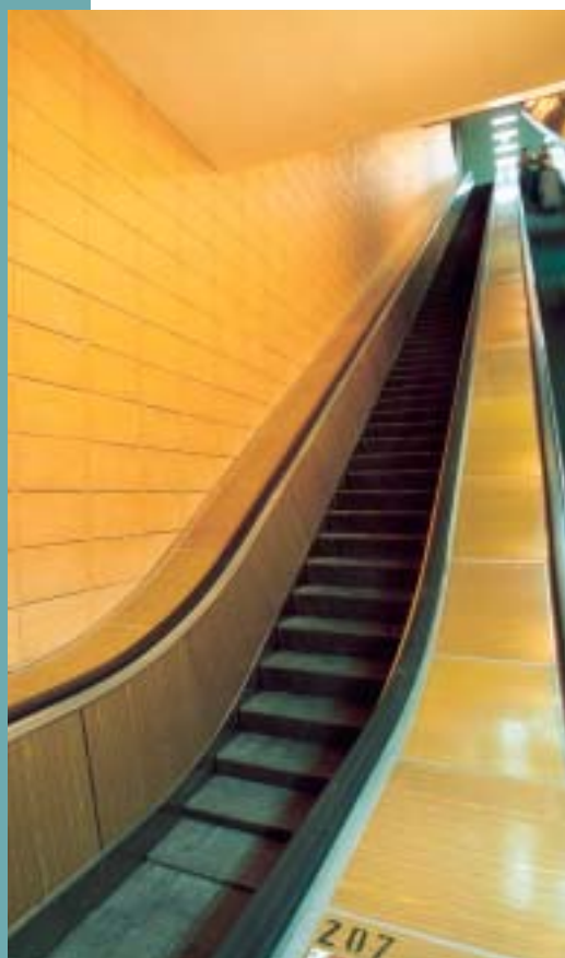
Obr. 7 Eskalátorový objekt stanice IB Florenc po provedení sanace
