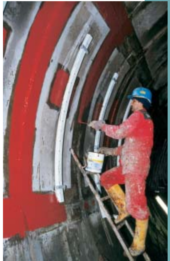
Obr. 3 Vlevo – aplikace první červené vrstvy Mediatan 36-1, vpravo – ošetření spáry pomocí Mediatan 701-T primer Fig. 3 On the left – application of the first red layer of Mediatan 36-1; on the right – treatment of the joint with Mediatan 701-T primer
