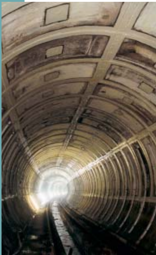
Obr. 1 Pohled do traťového tunelu Ø 5,1/5,5 m se sanovanými ložnými a styčnými spárami železobetonových tubinků
