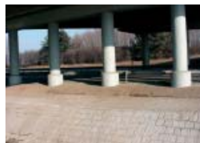
Obr. 5 Zesílení sloupů ochrannou přibetonávkou – stav po rekonstrukci
