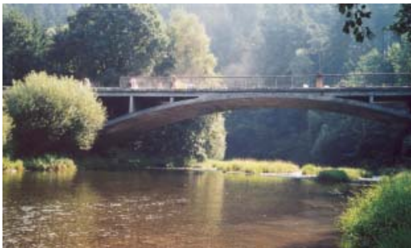
Obr. 1 Celkový pohled na most přes řeku Moravici v Kružberku před opravou
