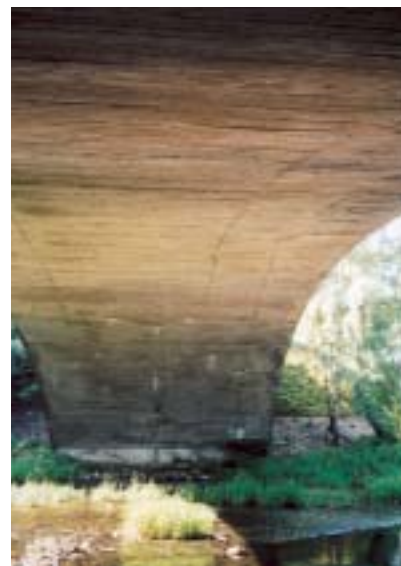
Obr. 3 Hrubý a otevřený povrch betonového mostního oblouku
