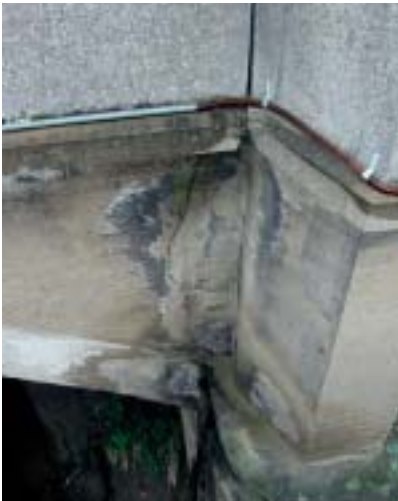
Obr. 4 „Divoká“ dilatace před opravou Fig. 4 „Wild“ dilatation before the repair
