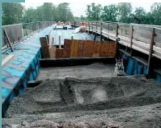
Obr. 8 Ukládání a hutnění lehkého mezerovitěho betonu na podpěře
