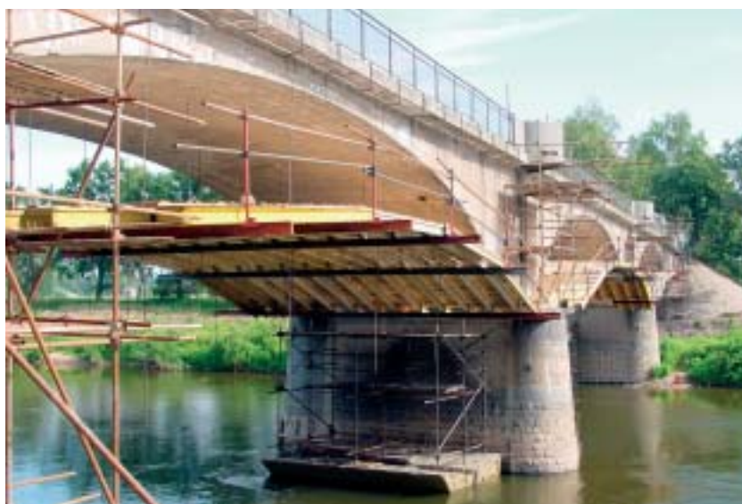
Obr. 4 Zavěšené lešení pod celým mostem a ponton u pilíře mostu
