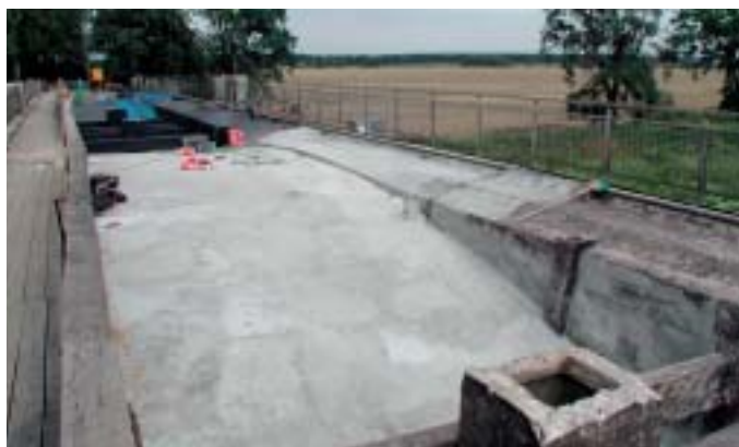
Obr. 5 Sanování povrchu klenby pod izolací a izolování na penetrační nátěr Fig. 5 Maintenance of the arch surface below insulation and application of insulation on the filler coat
