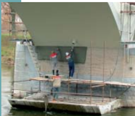
Obr. 7 Sanační omítka na spodní stavbě, nanášená z pontonu
