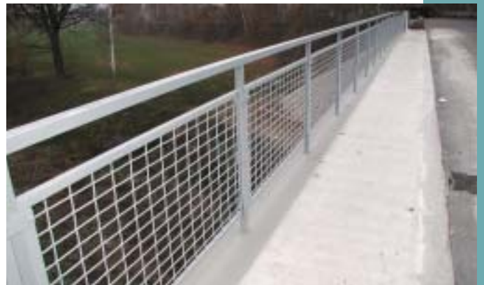
Obr. 10 Nové zábradlí a římsa Fig. 10 New railing and cornice
