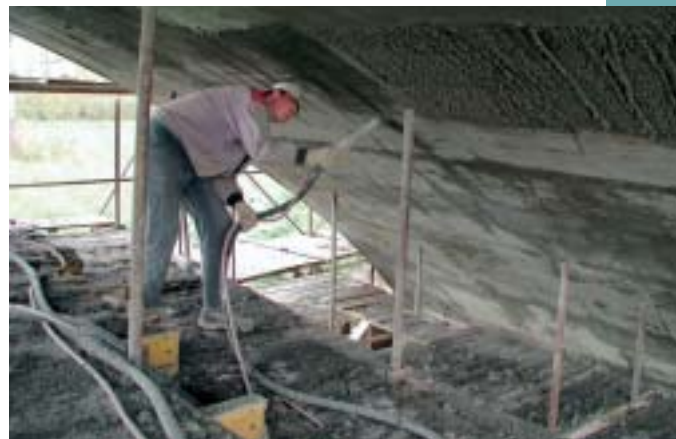
Obr. 6 Nástřik sanační omítky na oblouk mostu Fig. 6 Spraying of sanitation plaster on the bridge arch
