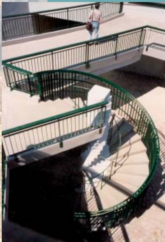
Opravené schodiště a lávka pro pěší v areálu nemocnice Na Bulovce v Praze Repaired staircase and footbridge in the area of the hospital Na Bulovce in Prague
