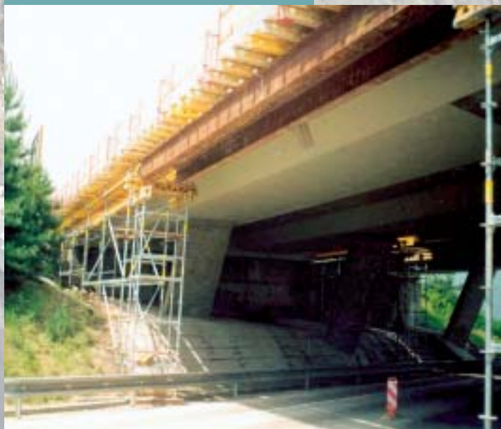
Rekonstrukce mostu D11-020 Bříství, sanace podhledu a betonáž říms Reconstruction of D11-020 bridge in Bříství
