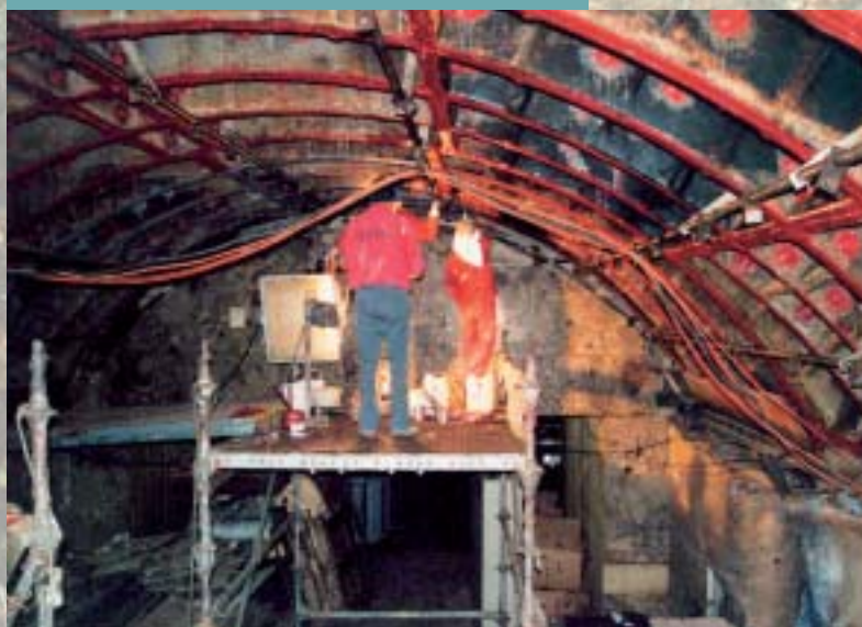
Těsnění středního tubusu stanice metra Můstek Sealing of the middle tube of the M_stek metro station
