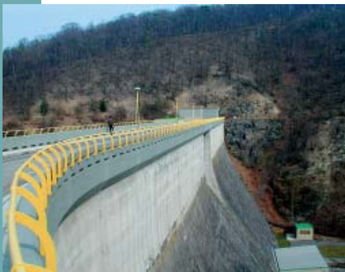
Obr. 1 Oprava Vodního díla Klíčava Fig. 1 Reconstruction of the Klíčava hydraulic structure
