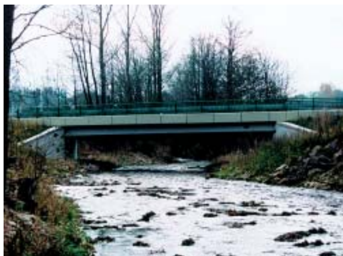
Obr. 6 Most u obce Zlatý Potok, nově vybudovaný 20 m po proudu řeky Fig. 6 Bridge near Zlatý Potok village, newly built 20 m downstream
