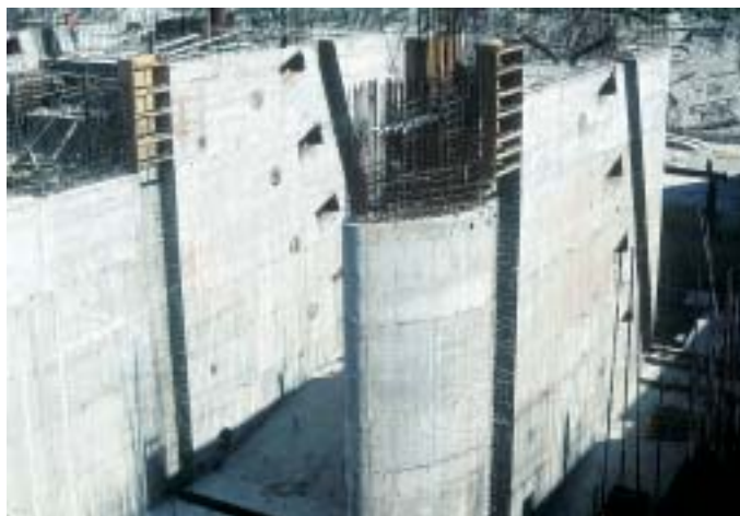
Obr. 10 Mrazuvzdorné betóny vtokových pilierov elektrárne Fig. 10 Frost resistance concretes of inlet piers in the water power station
