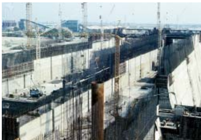
Obr. 3 Betonáž plavebných komôr Fig. 3 Concreting of navigation chambers
