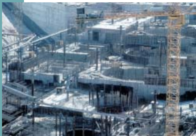
Obr. 8 Betonáže masívnych konštrukcií Fig. 8 Concreting of massive structures
