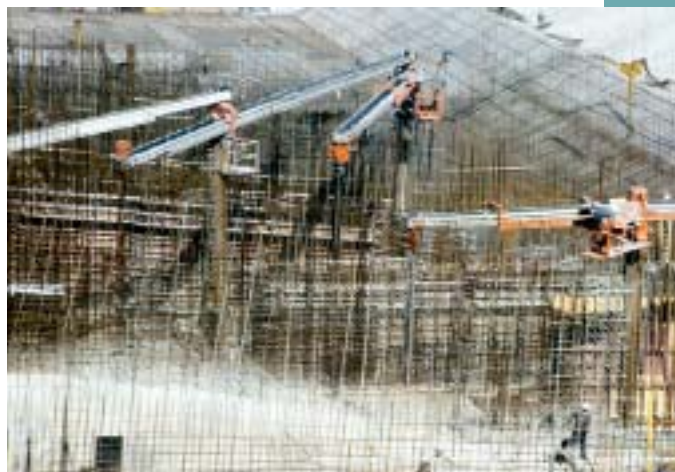
Obr. 11 Armovacie práce na vodnej elektrárni Fig. 11 Reinforcement works in the water power station
