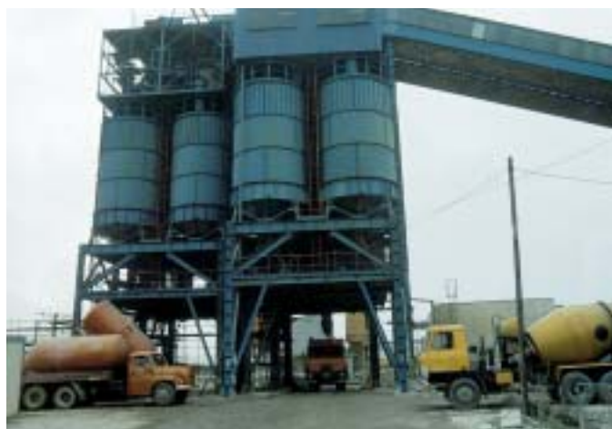
Obr. 9 Betonárky Elba 120 s automatickým riadením výroby Fig. 9 Mixing plants Elba 120 with automatic production control
