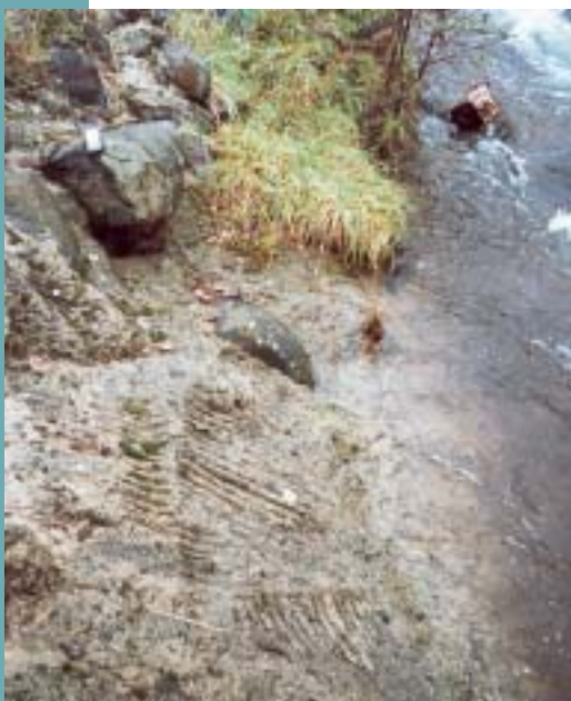
Obr. 7 Finální úprava povrchu betonu ocelovými hráběmi
