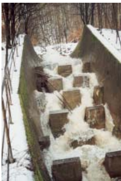
Obr. 3 Betonové šachovité rozrážeče Fig. 3 Concrete checkered baffle-blocks
