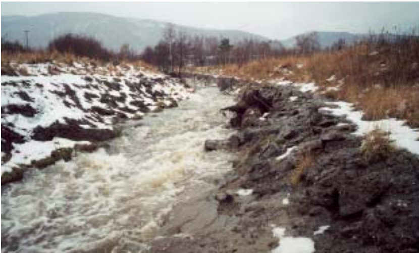
Obr. 4 Lichoběžníkový profil koryta opevněný prolévaným kamenným záhozem
