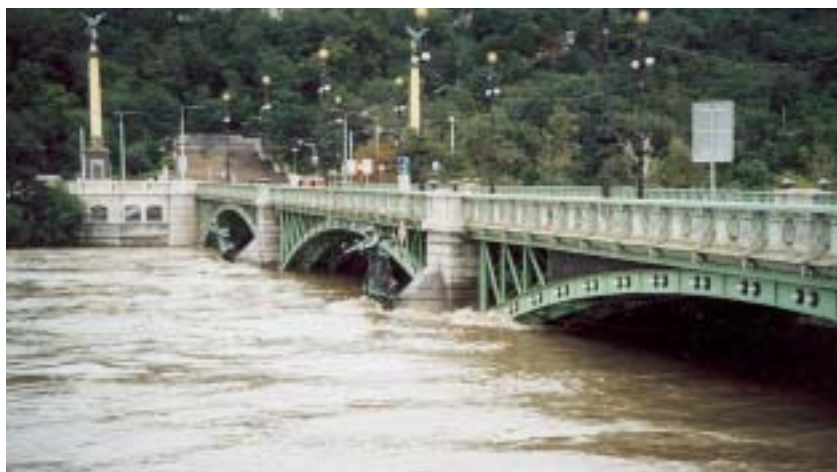
Obr. 8 Pohled na Čechův most při povodni v srpnu 2002, foto autor
