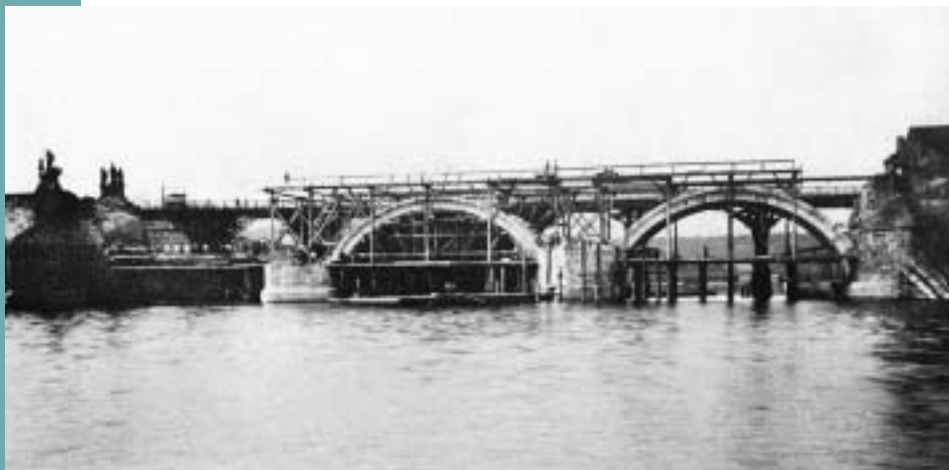
Obr. 2 Pohled na Karlův most během opravy pilířů 5 a 6 v roce 1892 [2]
