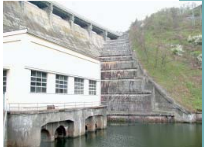
Obr. 4 Pohled na budovu spodních výpustí a kaskády (před povodní) Fig. 4 View of the building of the bottom outlets and cascade (before the flood)
