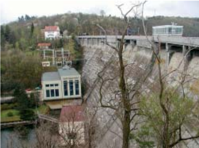
Obr. 3 Pohled na vzdušný líc přehrady Vranov z levého břehu Fig. 3 View of the downstream face of the dam Vranov as seen from the left bank
