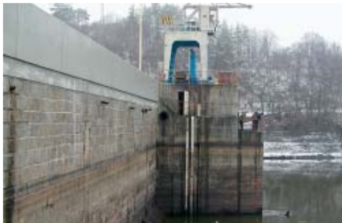
Obr. 2 Obklad návodního líce přehrady Kníničky Fig. 2 Lining of the upstream face of the dam Kníničky
