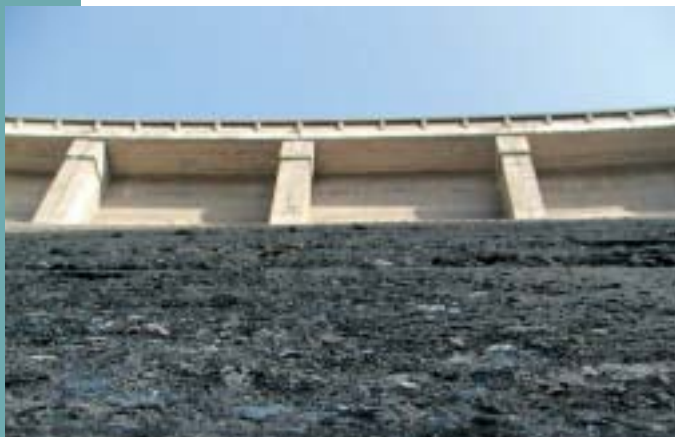
Obr. 1 Detail vzdušního líce přehrady Vír Fig. 1 Detail of the downstream face of the dam Vír
