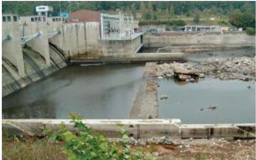
Obr. 8 VD Kamýk, porucha vývaru (blok betonu vytržený ze dna vývaru a porušený práh)
