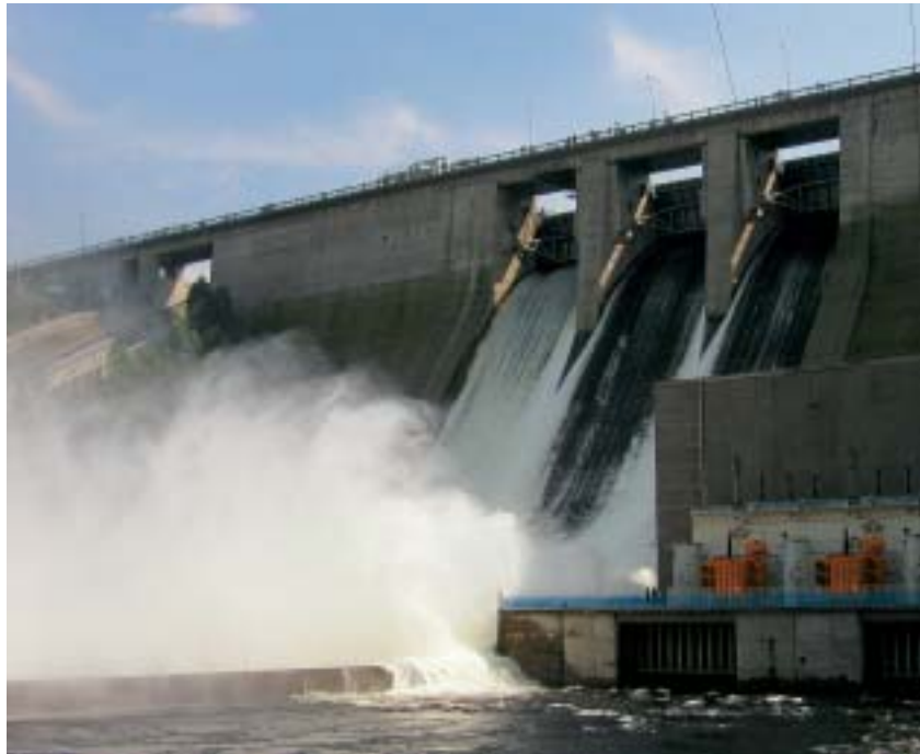
Obr. 4 VD Orlik, voda vytéká větracími otvory zaplaveného skladu umístěného pod korunu přehrady
