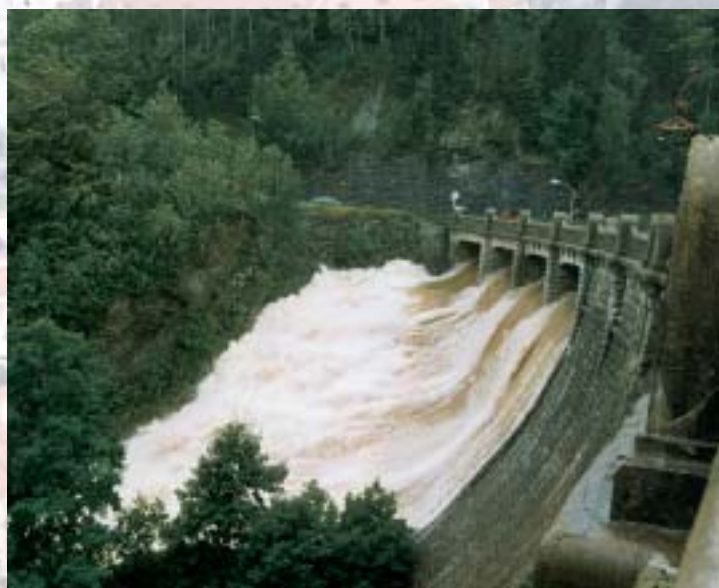
VD Labská, Labe pod Špindlerovým Mlýnem - koronový přeliv za povodně v červenci 1997 Labská HS, the Elbe below Špindlerův Mlýn - crest spillway during the flood of July 1997
