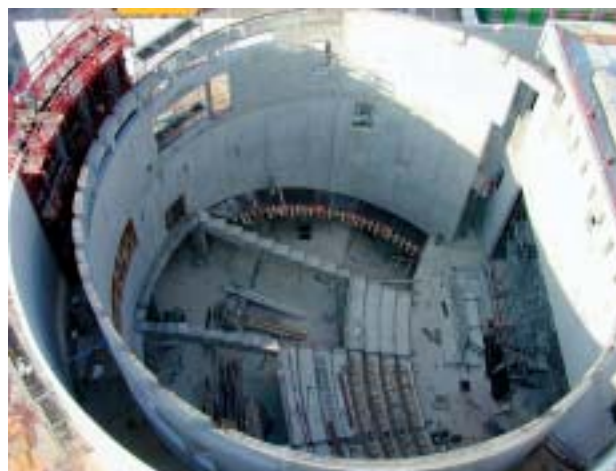
Obr. 3 Výstavba vodojemu za použití speciálních přísad MBT
