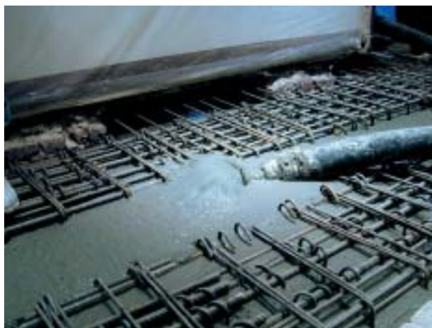
Obr. 2 Betonáž silně vyztužených mostních prvků samozhutňujícím betonem s přísadou Glenium
