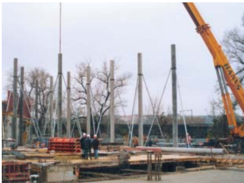
Obr. 4 Vztyčení sloupů v severním průchodu
