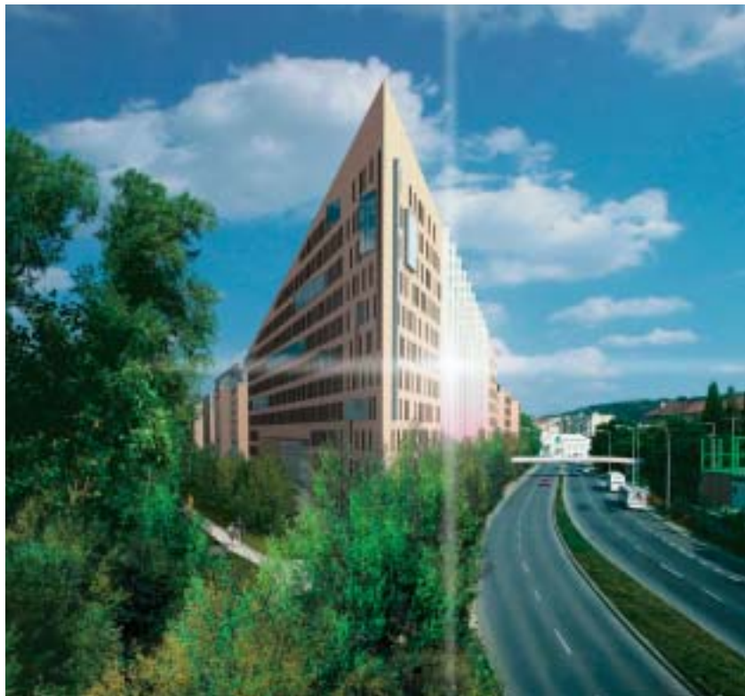
Obr. 2 Příd' domu – počítačový obraz Fig. 2 Bow of building – computer picture
