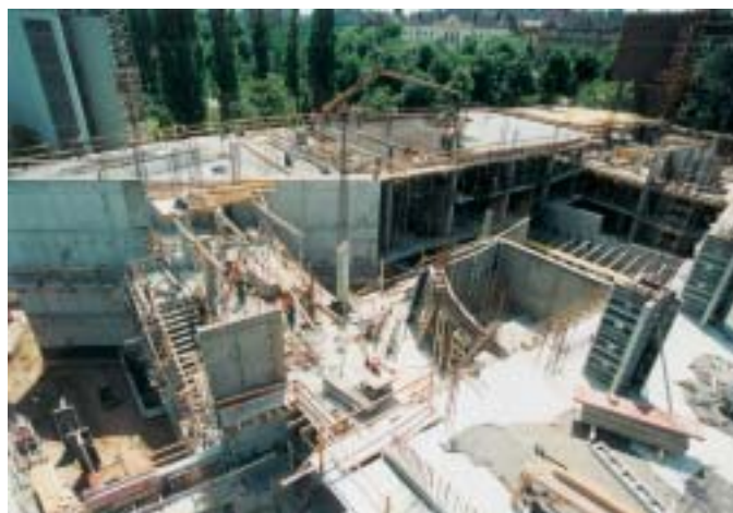
Obr. 8 Rozestavěné jižní křídlo s komunikačním krčkem a základem budoucího atria
