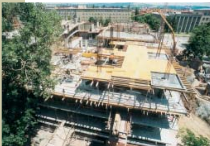
Obr. 7 Bednění těžkého hřibového stropu skladů knižního fondu
