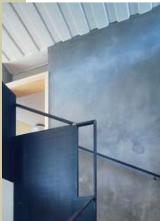
Obr. 8 Prostor schodiště s monolitickým betonovým stropem
