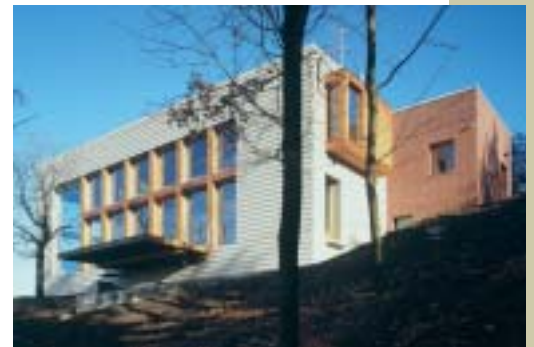
Obr. 11 Vila v Roudnici nad Labem, pohled ze zahrady na režné betonové stěny
