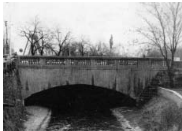
Obr. 3 První betonový most v Čechách z roku 1896 přes Rokytku v Praze-Libni
