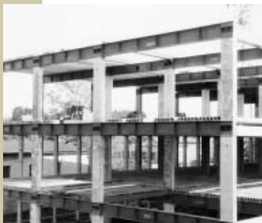
Obr. 2 Montáž skeletu, Lomnice nad Popelkou Fig. 2 Frame assembling, Lomnice nad Popelkou
