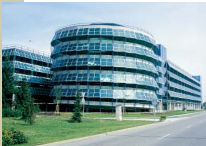
Obr. 1 Pohled na budovu s nárožní výjezdovou rampou Fig. 1 View of the building with the outside corner exit ramp
